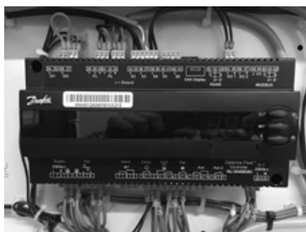
Imagem 3: Cablagem normal
