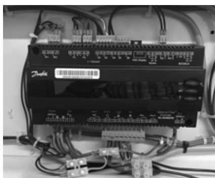
Abbildung 4: Vorübergehende Verdrahtung
