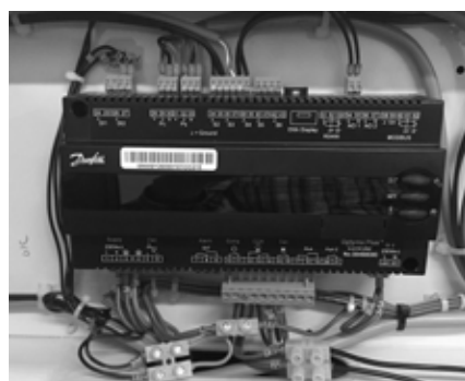
Rysunek 4: Okablowanie tymczasowe
