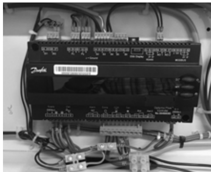
Рис. 4: Временное подключение
